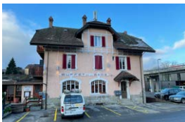
Lutry (VD) Route de la Conversion 289
